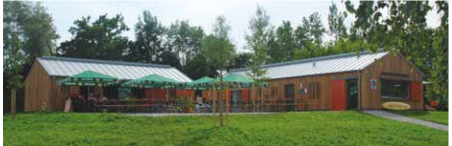
Neues Funktionsgebäude für die Wasserwacht mit Umkleide, Dusche, Toiletten und Kiosk
