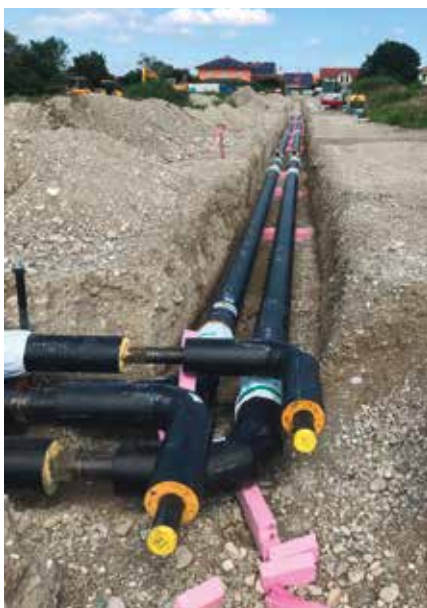
Fernwärmeleitung bei einem Projekt der EGIS eG (Quelle: EGIS eG)
