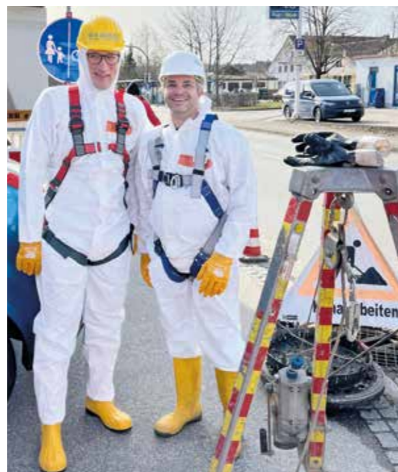
Bürgermeister B. Dittmann und Baustellenleiter M. Heuwieser vor dem Abstieg in den Marktler Untergrund
